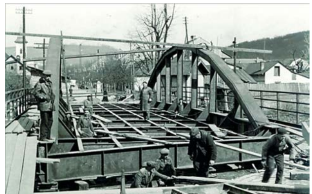
Reșița - Pod din oțel sudat, construit în 1931
