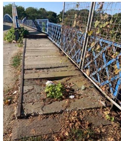
Amplasament și montaj module de balustradă înspre exteriorul pasarelei pietonale adiacente podului pe latura estică
