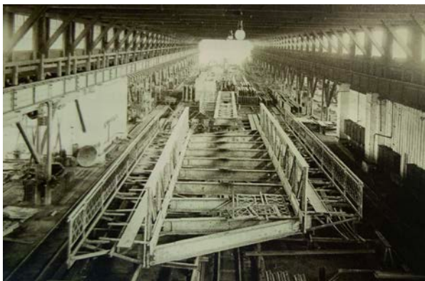
Reșița - Fabrica de poduri. Hala de montaj pentru asamblarea grinzilor de poduri - Fotografie din jurul anului 1925
