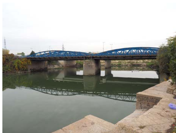
Fotografie realizată în noiembrie, 2020 - se poate distinge prezența pasarelei pietonale - vizibilitate clară a consolelor metalice sub pasarelă (urme absente în fotografia de epocă)
