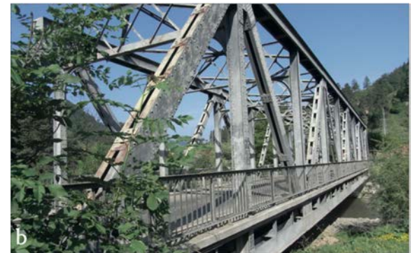
Comănești - Podul de fier peste râul Trotuș construit la Reșița în anul 1932
