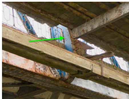
Fixare consolă prin montare cornier intermediar de talpa montanțului console situate în apropierea culeilor
